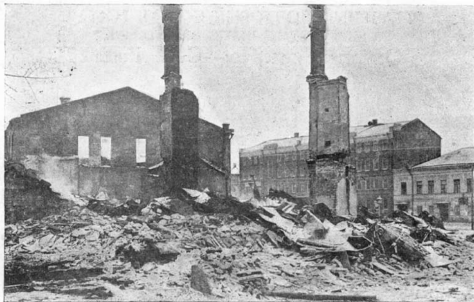
Un bâtiment brûlé à la rue Koudrinskaya.
